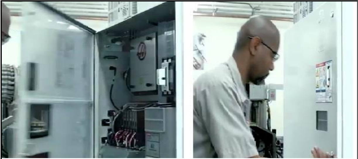
١٤- يقوم الطالب بتحديد مكان وصلة كبل الحساس الخاضع للاختبار على لوحة ال I/O board.
