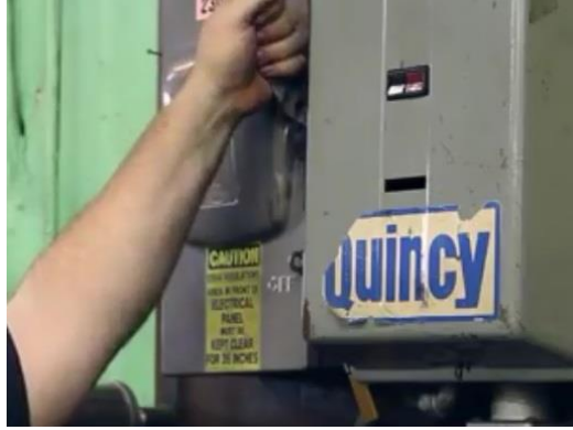
شكل رقم ١٥: فصل مفتاح الكهرباء الرئيسي
