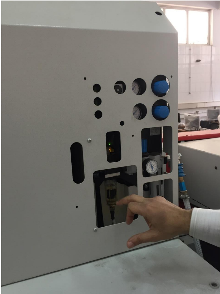
شكل رقم ٢٧: فحص مستوى زيت وحدة خدمة الهواء
