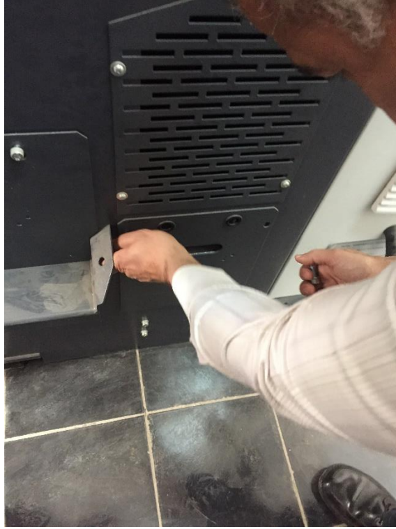
شكل رقم ٢٩: فك مسامير قاعدة حامل موتور ظلمبة زيت التبريد
